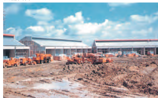
整備工場等の建設
