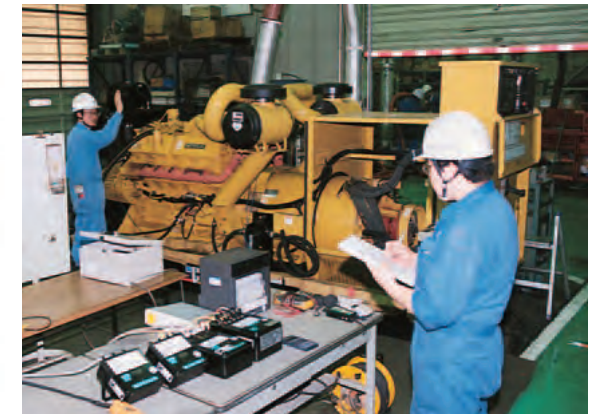
発電機の負荷テスト 1500kVAまでの大型発電機負荷テストに対応でき、NEGA(日本内燃力発電設備協会)基準に基づき試験を実施します。
