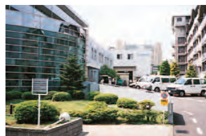
東京工場:敷地3,700m 2
