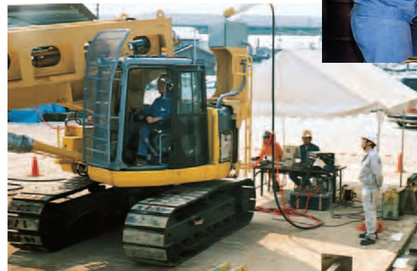
転炉解体機の応力テスト
